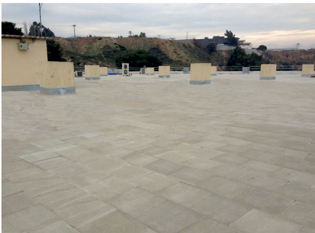
Εφαρμογή θερμομόνωσης δώματος με σύνθετο θερμομονωτικό πλακίδιο πλακίδιο MARSIPUS TL.
