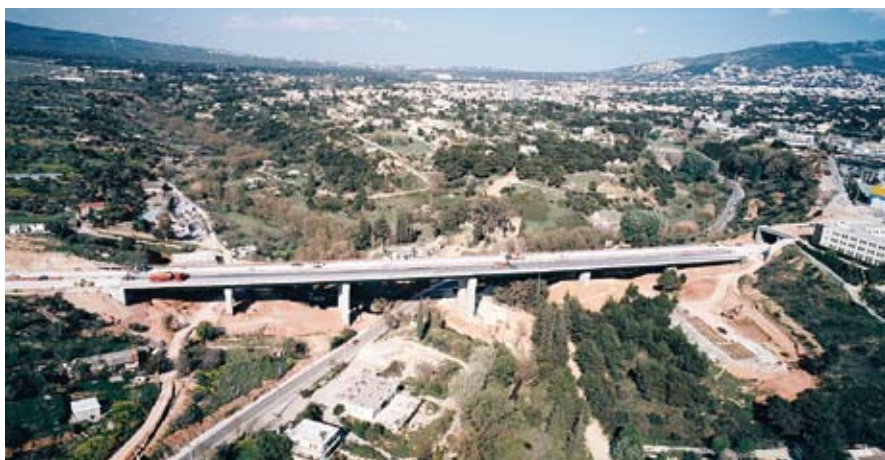
Κοιταδογέφυρα προς Ολυμπιακό Χωριό
