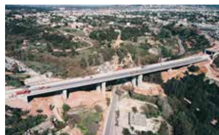
Γέφυρα προς Ολυμπιακό Χωριό
